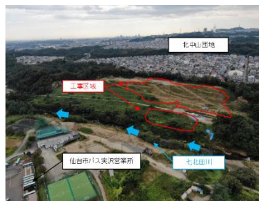
施工前の状況 （令和 4 年 2 月末現在）
